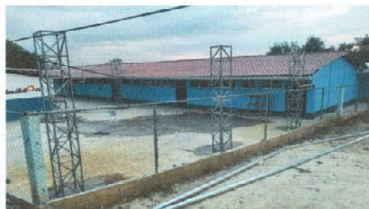
Foto 2: colocacion de canales y bajadas de agua pluviales.
