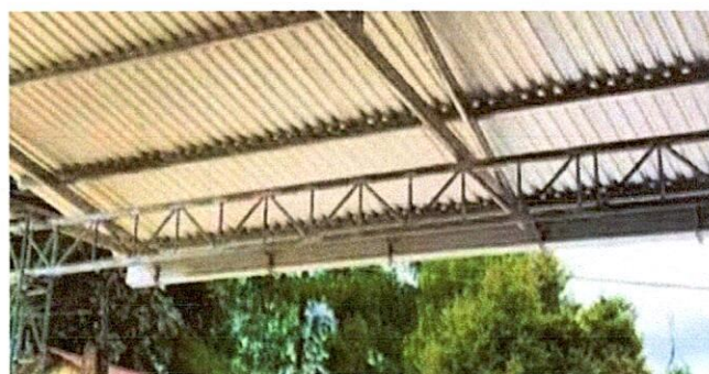
Foto 2: colocacion de canales y bajadas de agua pluviales.
