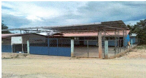
Foto 1: colocación de techado en area descubierta.
