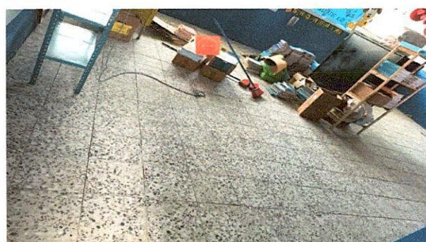
Foto 4: colocacion de piso de granito.
