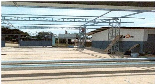
Foto 1: colocación de techado en area descubierta.
