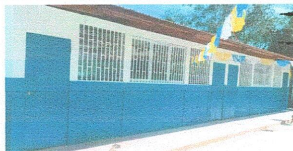
Foto 4: colocacion de canales y bajadas de agua pluviales.
