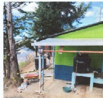
Foto 4: Sustitución de bajada de agua pluvial, tubo PVC de 3 pulgadas
