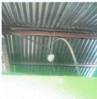
Foto 7: Sustitución de plafoneras, focos, tomacorrientes y cableado eléctrico en la cocina
