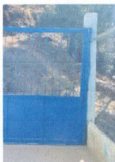
Foto 9: Sustitución de chapas de metal
