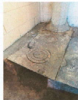
Foto 8: Sustitución de plancha de metal de 3 ornillas
