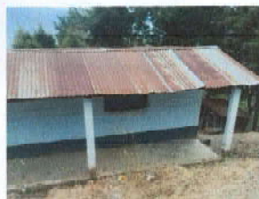
Foto 5: Pintura en muros exteriores e interiores
