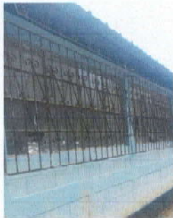
Foto 3: Mantenimiento a balcones de metal, lijado y pintado con pintura anticorrosiva
