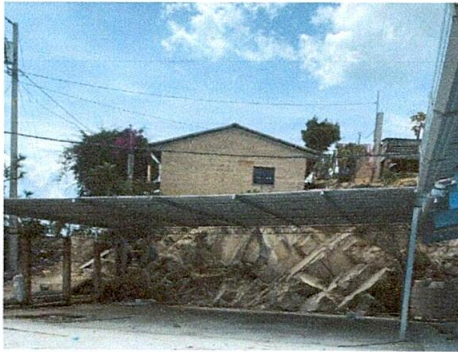
Foto 1: sustitución de techo de lámina troquelada calibre 26
