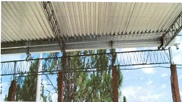
Foto 5: canales y bajadas de agua pluvial
