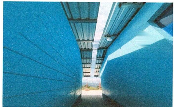
Foto 6: pintura en muro exteriores e interiores.
