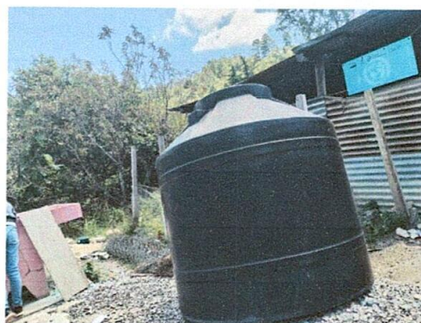
Foto 10: reparación y mantenimiento de cisternas/depósitos de agua.
