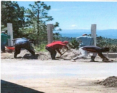
Foto 3: sustitución de piso de torta de concreto.
