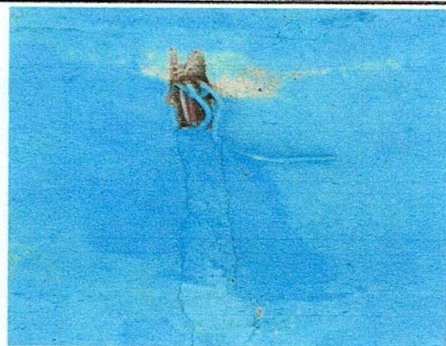
Foto 15: sustitución de ducto eléctrico.
