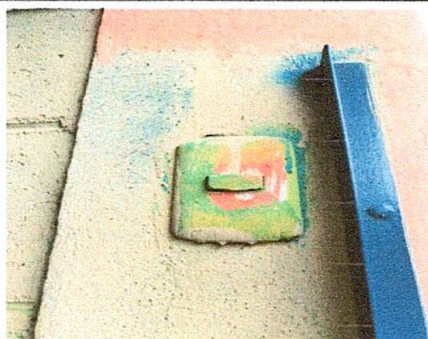
Foto 19: sustitución de apagadores simples.
