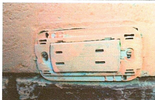
Foto 18: sustitución de tomacorrientes dobles.
