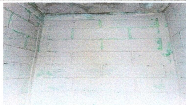
Foto 8: pintura en muros exteriores e interiores.
