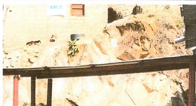
Foto 7: sustitución de canal de metal.
