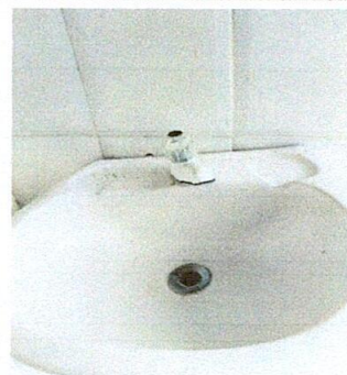
Foto 10: sustitución de lavamanos.
