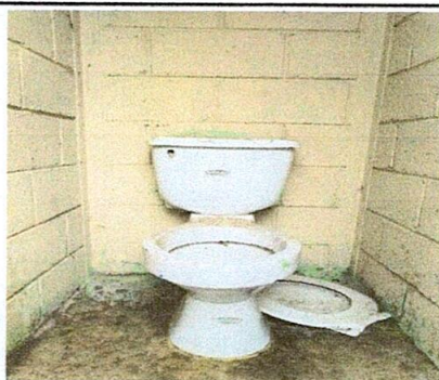
Foto 9: sustitución de inodoros.
