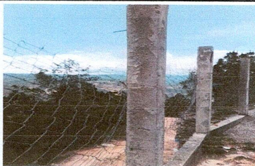
Foto 11: reparación de tubo hg y malla galvanizada.
