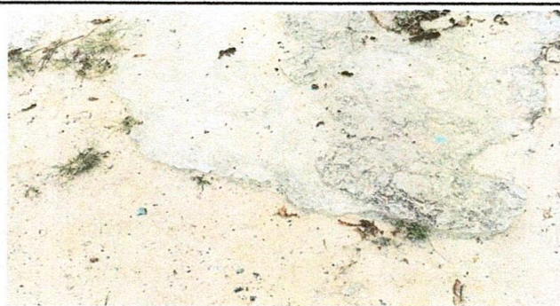
Foto 4: sustitución de piso de torta de concreto.
