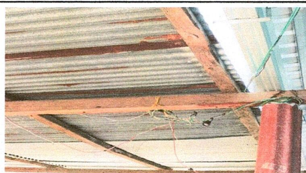
Foto 2: sustitución de elementos de fijación para lámina troquelada
