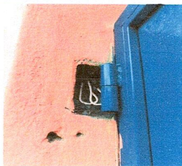
Foto 17: sustitución de cajas rectangulares.
