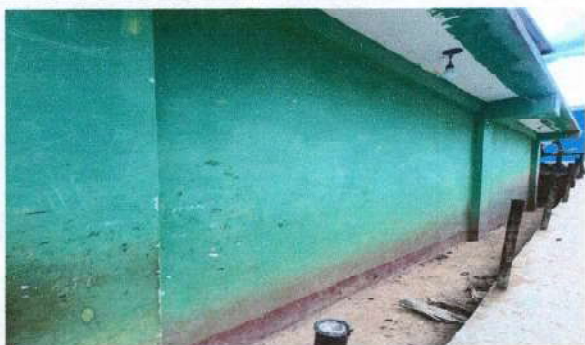
Foto 3: Pintura en muros exteriores e interiores
