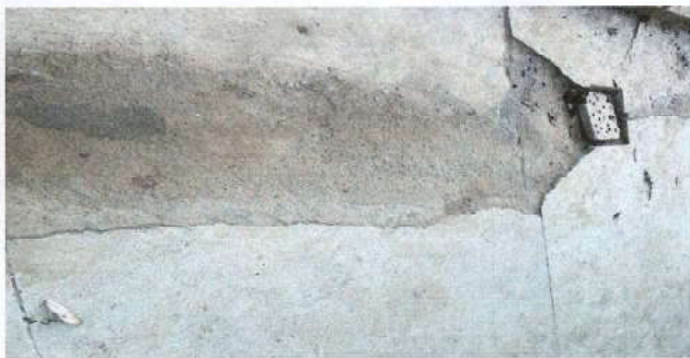
Foto 1: Sustrución de piso de torta de concreto
