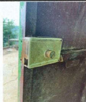
Foto 2: Sustrución de puertas de metal
