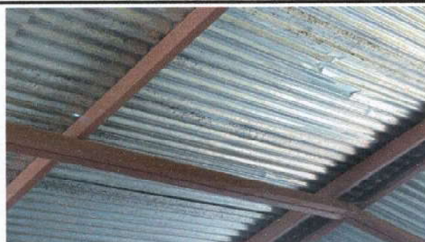
Foto 6: Sustrución de lámina
