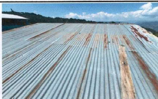
Foto 5: Sustrución de lámina
