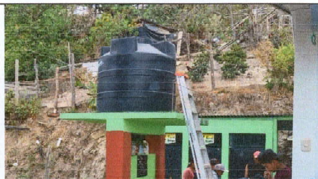
Foto 4: Sustitución de depósito de agua
