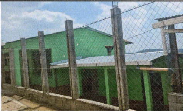
Foto 7: Reparación de muro con malla galvanizada
