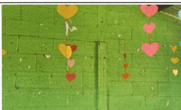
Foto 6: Repello de muro
