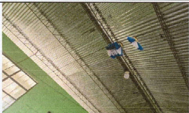
Foto1: Sustitución de lámina por lámina troquelada
