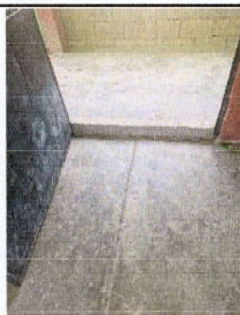
Foto 11: Sustitución de piso de torta de concreto
