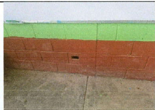
Foto 12: Sustitución de ducto eléctrico + accesorios
