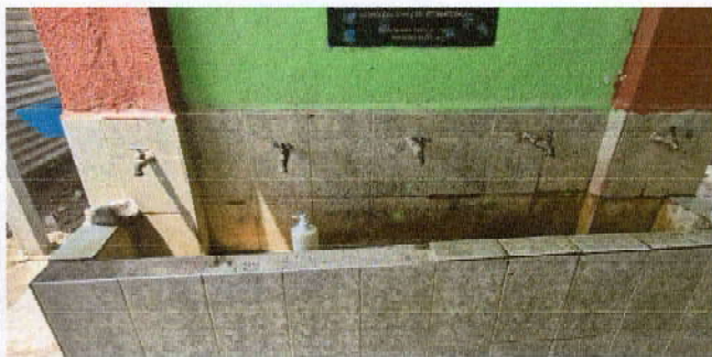
Foto 9: Sustitución de llaves de paso
