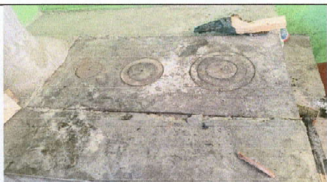
Foto 5: Sustitución de plancha de metal de 3 hornillas
