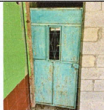
Foto 10: Sustitución de puerta
