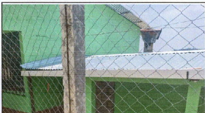
Foto 3: Sustitución canal de metal por metal calibre 26, con portante, tapones y bajadas
