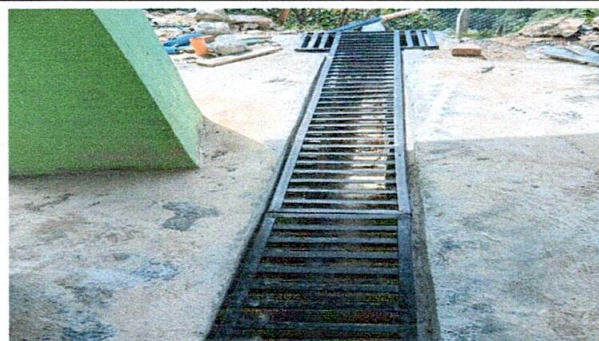
Foto 6: Mejoramiento de una rejilla en el área de los baños, para evitar que el agua en tiempo de lluvia ingrese dentro de los baños.
