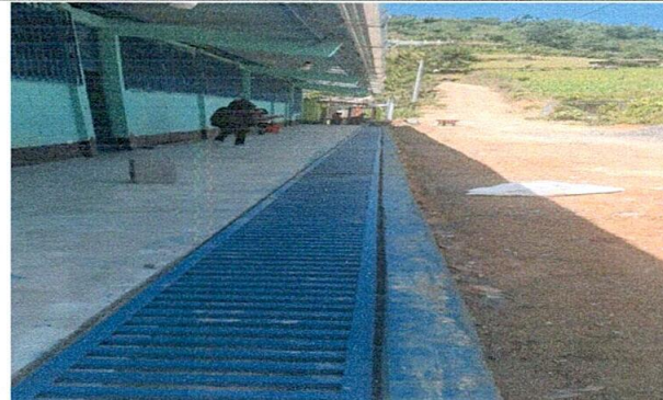
Foto 2: Reparación de cuneta de concreto y mejoramiento con rejilla para que corra el agua.
