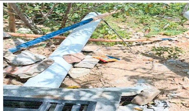
Foto 4: Reparación de la red de drenaje para prevenir y de las aguas pluviales.
