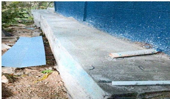
Foto 1: Mejoramiento de banqueta a un costado de la cocina.
