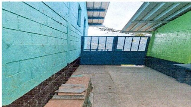
Foto 1: Sustrucción de Puerta de madera por puerta de metal.
