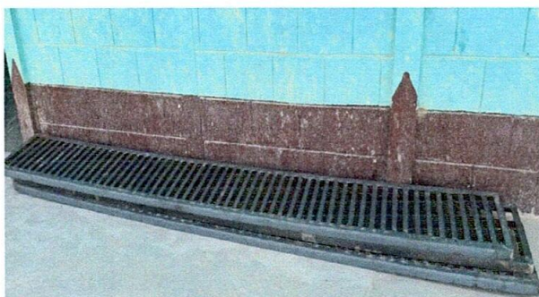
Foto 5: Mejoramiento de una rejilla en el área de los baños, para evitar que el agua en tiempo de lluvia ingrese dentro de los baños.
