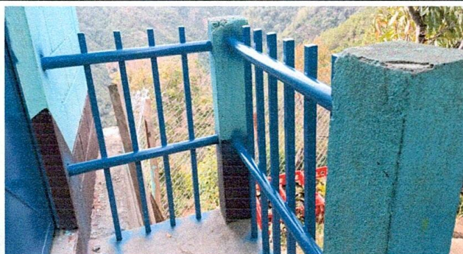
Foto 3: Mejoramiento de baranda para evitar que ingresen personas ajenas a la escuela y el ingreso de animales al huerto escolar.
