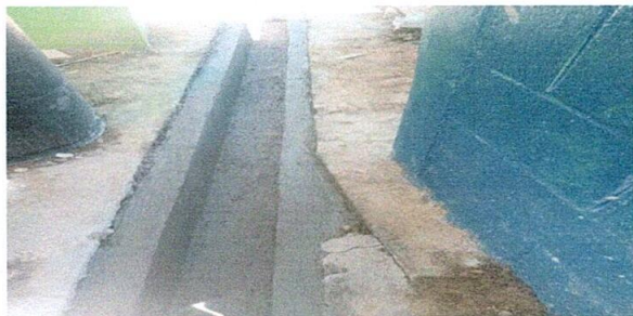
Foto 5: Mejoramiento de cuneta de concreto en el área de los baños.
