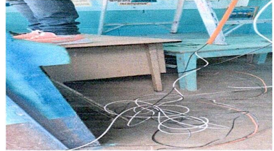
Foto 2: Repación del sistema eléctrico en toda la escuela.
