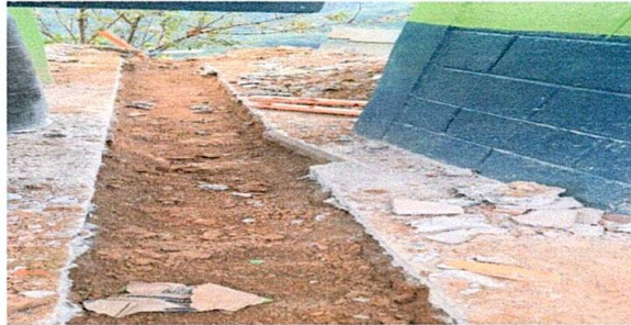
Foto1: Reparación de banqueta de concreto.
