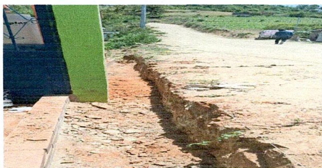
Foto 5: inicio de la construcción de un muro perimetral para prevenir que se derrumbe la tierra y afecte una parte del establecimiento.
