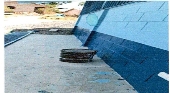
Foto 3: Pintura a muros exteriores e interiores del edificio de la EORM.
