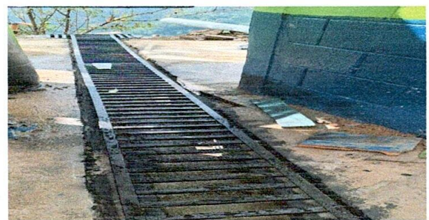
Foto 5: Mejoramiento de cuneta de concreto y colocación de rejilla en el área de los baños.
