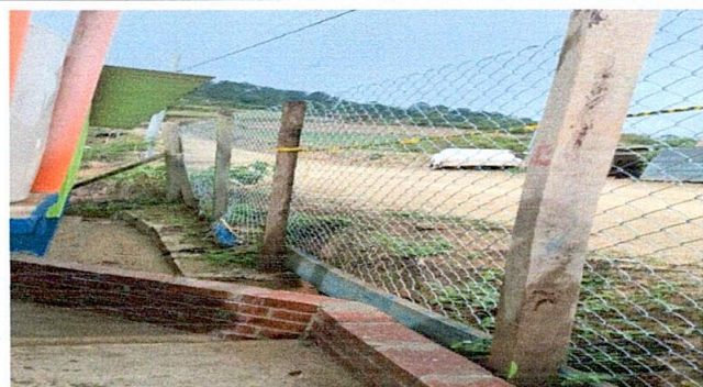
Foto 5: se necesita un muro perimetral para prevenir que se derrumbe la tierra y afecte una parte del establecimiento.
