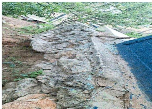
Foto 1: Reparación de cuneta de concreto, a un costado de la cocina para evitar que se deteriore el muro.
