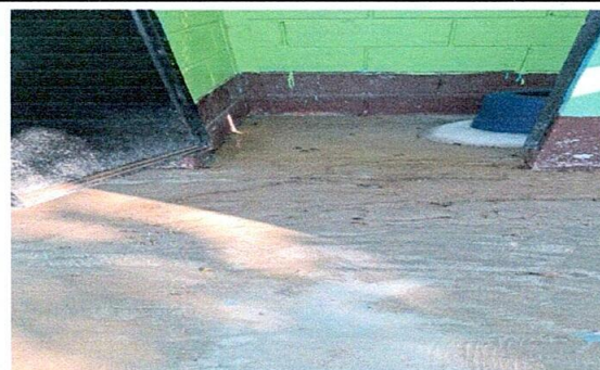
Foto 6: Mejoramiento de una cuneta con rejilla en el área de los baños, para evitar que el agua en tiempo de lluvia ingrese dentro de los baños.
