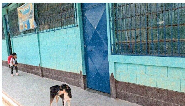
Foto 3: Pintura a muros exteriores e interiores de toda la escuela.
