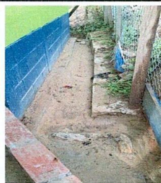
Foto 2: Es necesaria la reparación de las cunetas de concreto y mejoramiento con rejillas para evitar accidentes y para que corra el agua.
