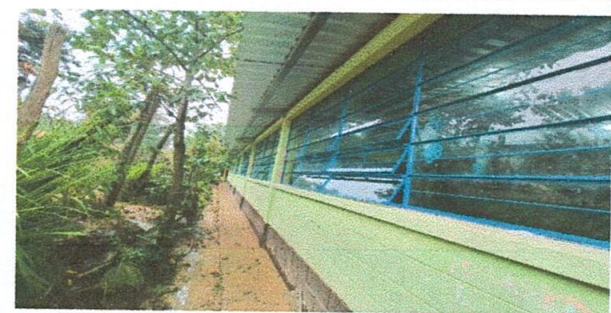
Foto 11: Balcones y vidrios terminados
