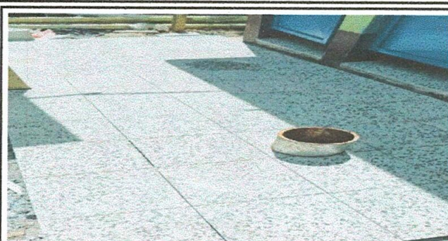
Foto 8: Cambio de piso de torta por piso de granito en entrada a sanitarios
