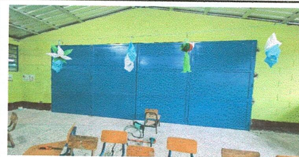
Foto 12: Puerta divisoria de aulas terminada
