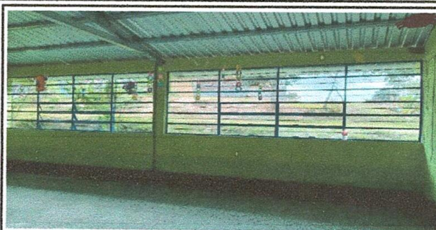
Foto 2: Reparación y mantenimiento de ventanas de aulas
