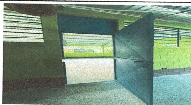
Foto 4: Sustitución de piso de granito en aulas y patio
