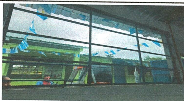
Foto 6: Reparación y mantenimiento de ventanas de aulas
