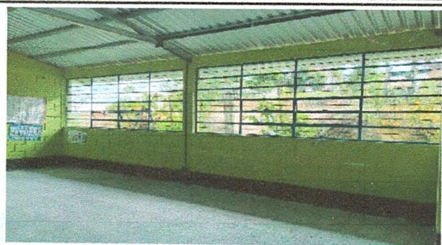
Foto 1: Sustitución de piso de torta por piso de granito en aulas
