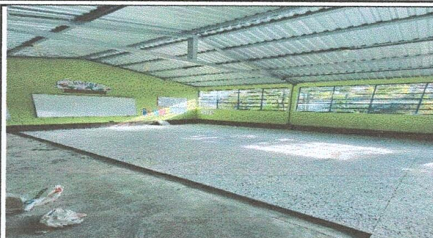
Foto 2: Proceso de instalación de piso de granito en aulas
