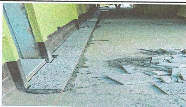
Foto 4: Proceso de instalación de piso de granito en patio
