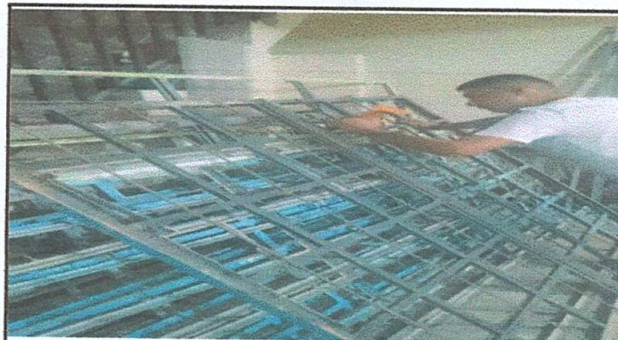
Foto 10: Proceso de mantenimiento y reparación de ventanas
