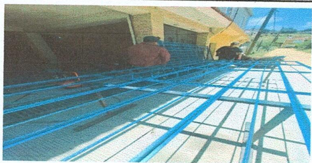
Foto 11: Proceso de mantenimiento y reparación de ventanas
