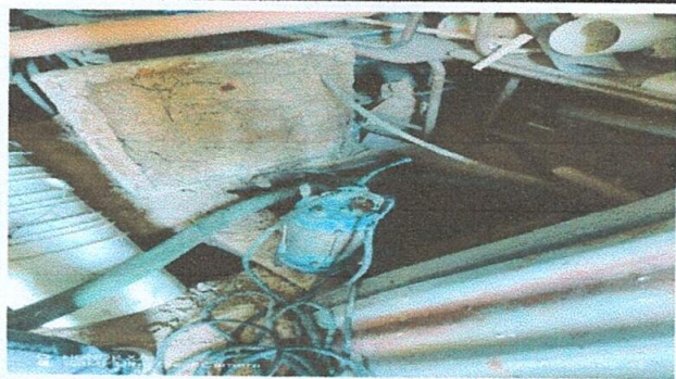
Foto 16: Proceso de limpieza de foza séptica
