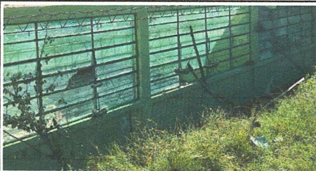
Foto 13: Mantenimiento de estructura metálica de las ventanas
