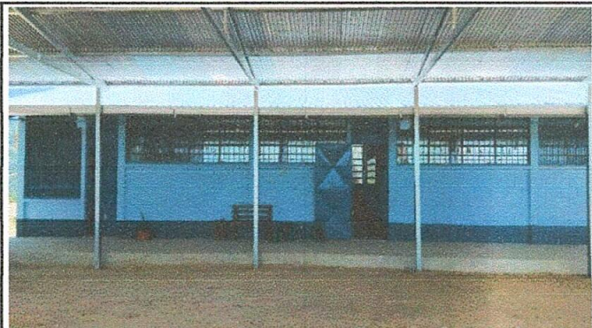
Foto1: Sustrucion de techo.
