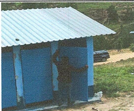
Foto 3: Sustrucion de puertas en servicio sanitario.
