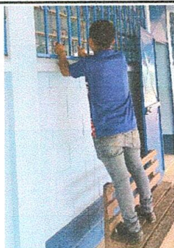
Foto 5: Sustrucion de de cubierto de lamina.
