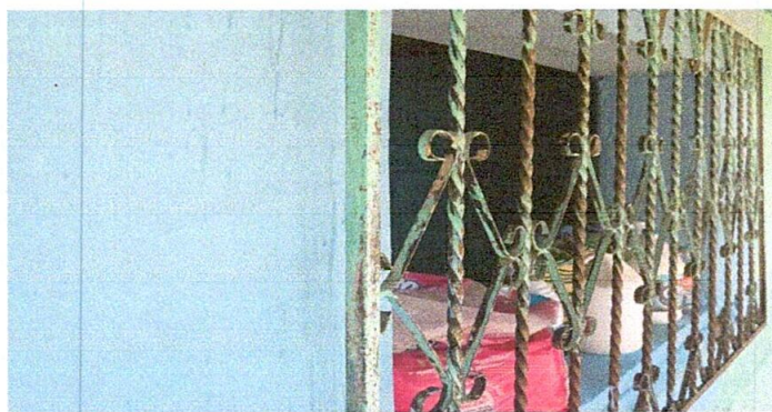
Foto 6: Sustitución de balcones de metal
