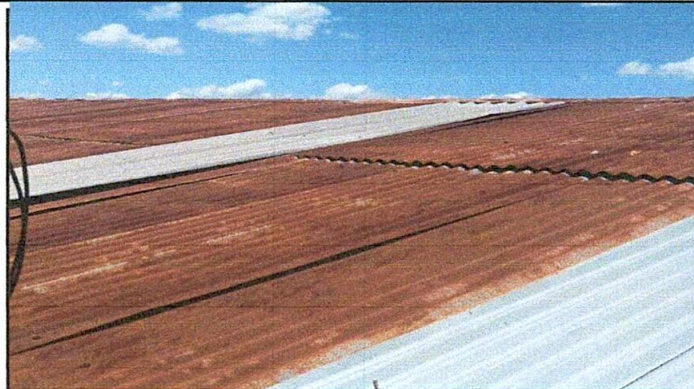
Foto1: Sustitución de cubierta de lámina
