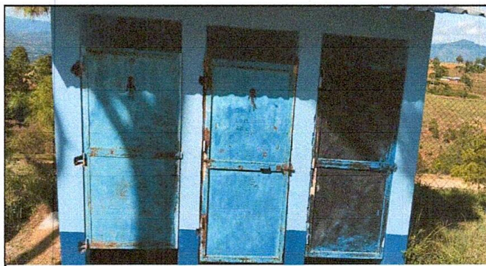
Foto 4: Sustitución de puertas en servicio sanitario
