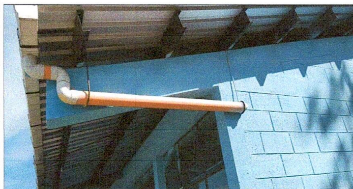
Foto 5: Bajada de agua pluvial
