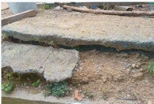
Foto 9: reparación de tapadera de caja
