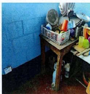
Foto 3: Sustitución de mejoramiento de mesas con cemento y azulejo.
