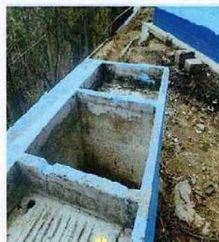
Foto 4: sustitucion de pilas con accesorios.
