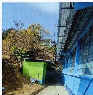
Foto 5: Sustitución de balcones de metal.
