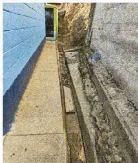
Foto 7: reparación de cuneta de concreto
