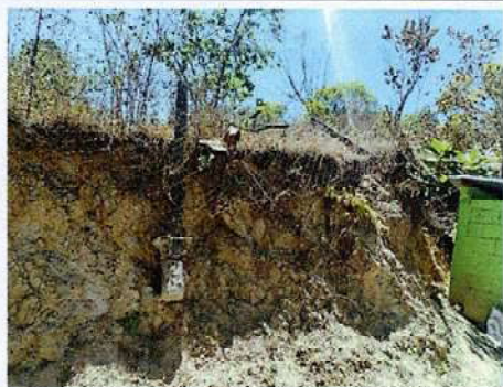
Foto 1: Reparación de tubo HG y malla galvanizada.
