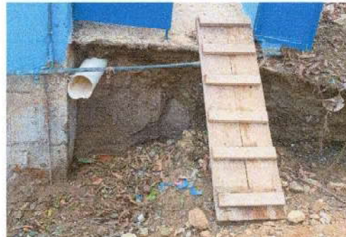
Foto 8: reparación de banqueta de concreto
