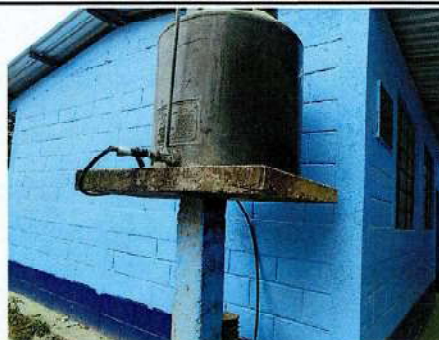
Foto 6: Sustitución de depósito de agua.
