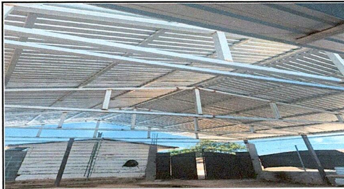
Foto 2: Finalización de Instalación de estructura y techo
