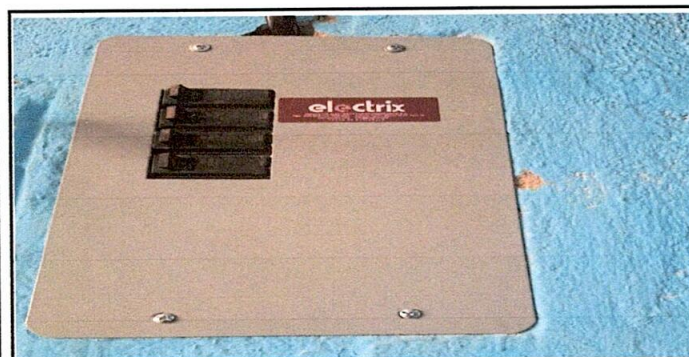
Foto 5: Instalación de caja y flipones
