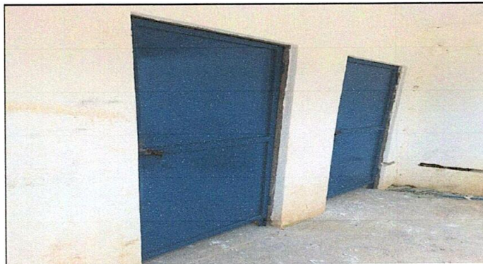
Foto 4: Instalación de puertas para baños
