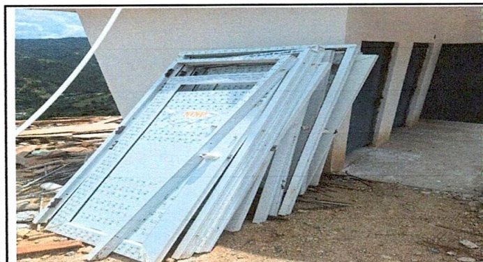
Foto 3: Retiro de puertas a sustituir
