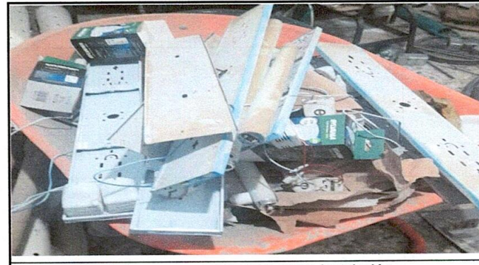
Foto 6: Retiro de lamparas y cables para nueva instalación
