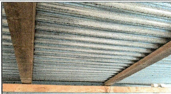
Foto 8: Estructura de madera a sustituir
