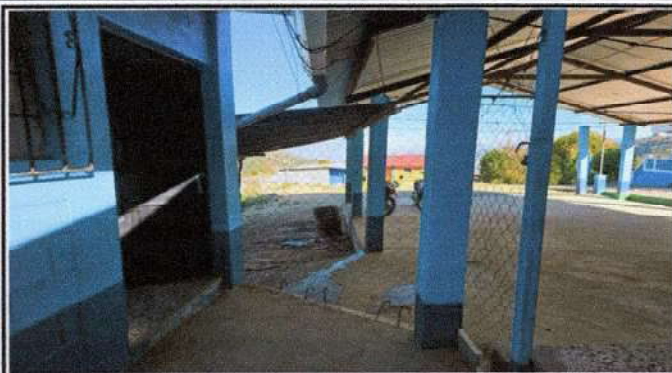
Foto 8: Sustritución de barandas de metal.
