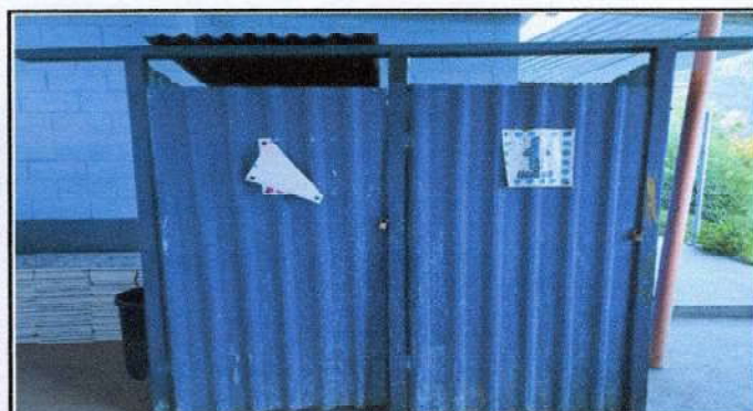
Foto 3: Sustrucción de puertas en servicios sanitarios.
