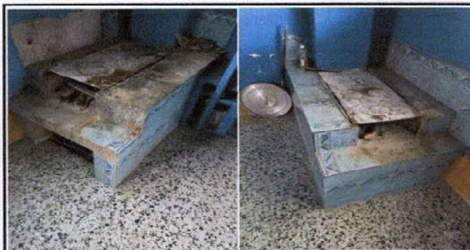
Foto 12: Mejoramiento de estufa rural.
