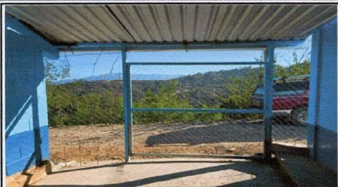
Foto 7: Sustritución de barandas de metal.
