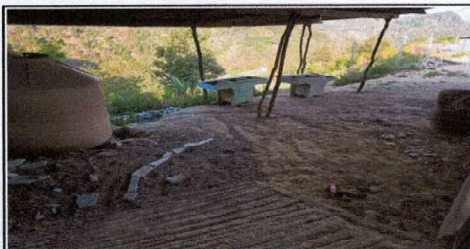
Foto 11: Reparación de planchas de concreto de patio.
