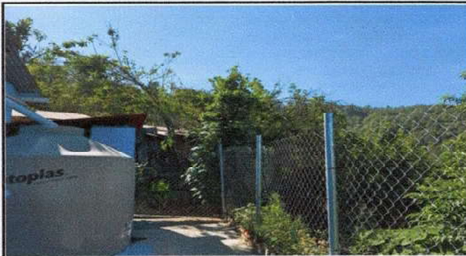
Foto 10: Reparación de tubo hg y malla galvanizada.
