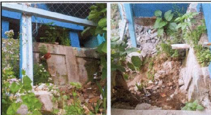
Foto 9: Reparación de muro perimetral.
