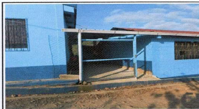
Foto 4: Sustrucción de portón de metal.
