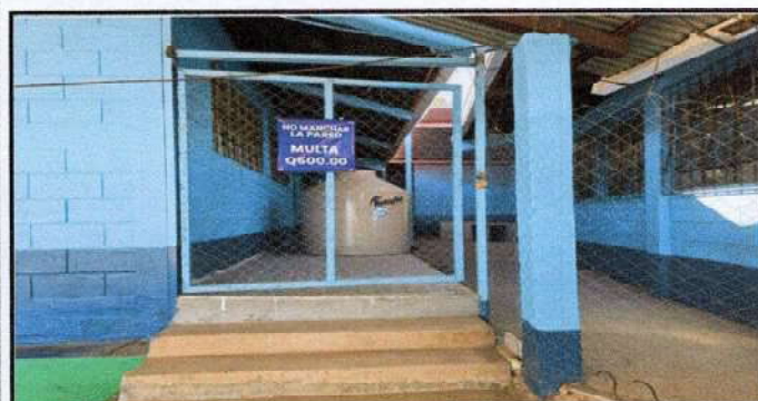
Foto 5: Sustrucción de portón de metal.
