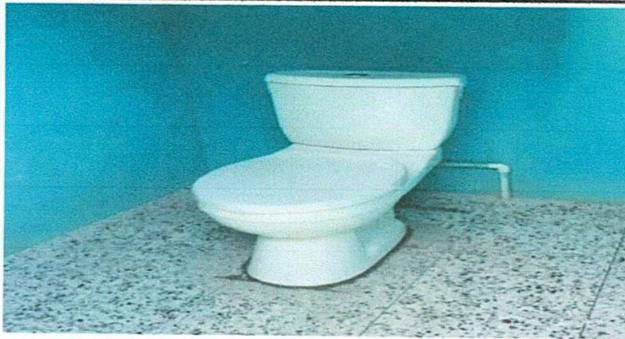
Foto 7: Sustrucción de sanitarios
