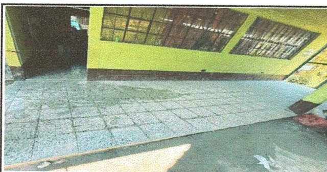
Foto 4: Sustrución de piso de torta de concreto por piso de granito en patio de aula
