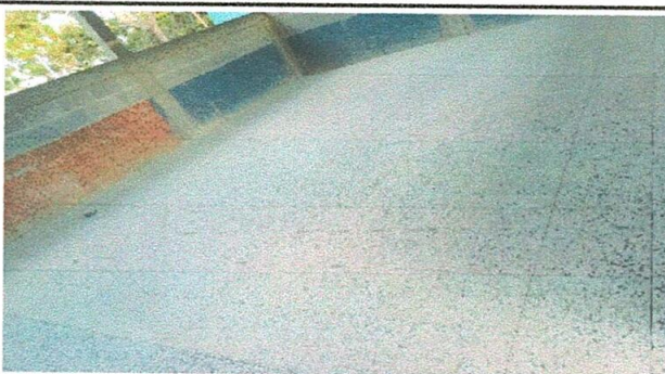
Foto 3: Sustrución de piso de torta de concreto por piso de granito en aulas
