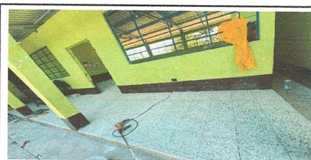
Foto 6: Sustrución de piso de torta de concreto por piso de granito en patio de aula
