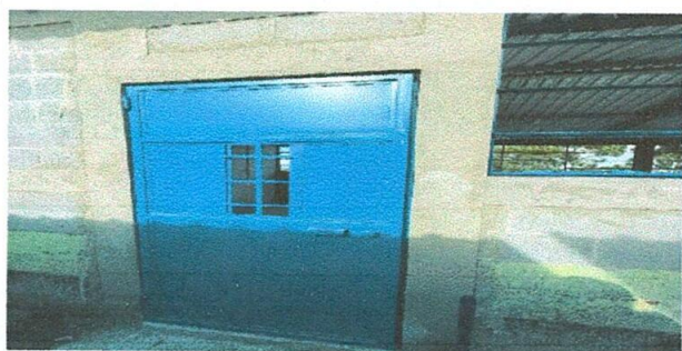
Foto1: Sustrución y mantenimiento de puertas en aulas
