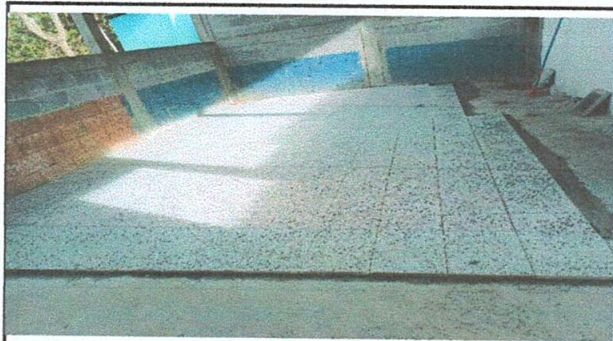
Foto 3: Proceso de sustitución de piso de torta de concreto por piso de granito en aula
