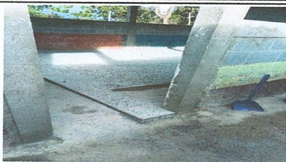
Foto 7: Proceso de sustitución de piso de torta de concreto por piso de granito en aula.
