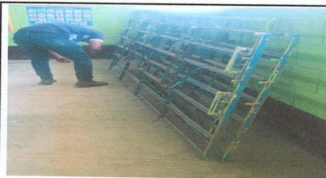
Foto 10: Proceso de mantenimiento de estructura de metal de ventana en aulas
