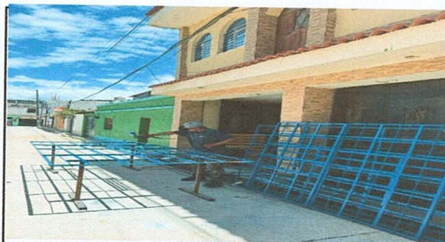
Foto 12: Proceso de mantenimiento de estructura de metal de ventana de aulas
