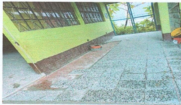
Foto 2: Proceso de sustitución de piso de torta de concreto por piso de granito en patio de aula
