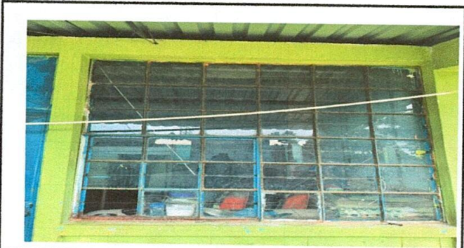
Foto 15: Mantenimiento de estructura de metal de ventana
