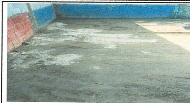
Foto 13: Sustitución de piso de torta de concreto por piso de granito por deterioro, en aula.
