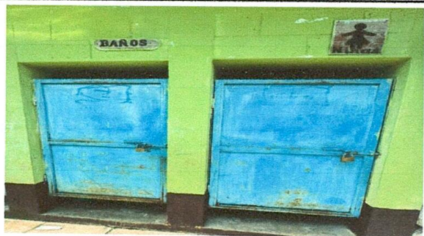
Foto 7: Mantenimiento de puertas de sanitarios
