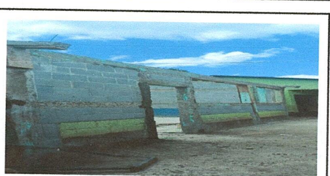
Foto 18: Mejoramiento de techo de aula ya que carece del mismo por ser aula nueva.
