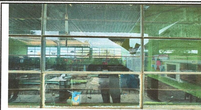
Foto 14: Mantenimiento de estructura de metal de ventana
