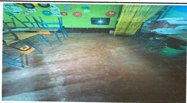
Foto 3: Sustrucción de piso de torta de concreto por piso de granito por deterioro, en aulas.
