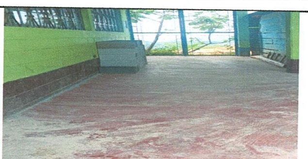
Foto 6: Sustrucción de piso de torta de concreto por piso de granito por deterioro, en corredor.
