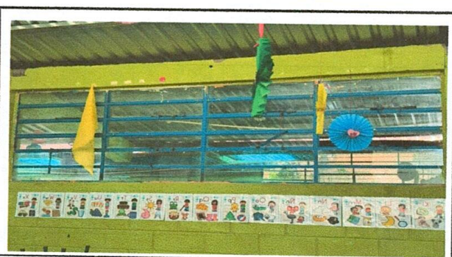
Foto 16: Mantenimiento de estructura de metal de ventana
