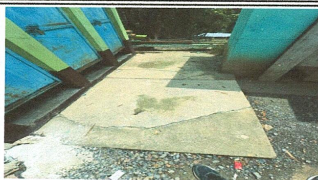
Foto 2: Sustrucción de piso de torta de concreto por piso de granito por deterioro, en sanitarios.
