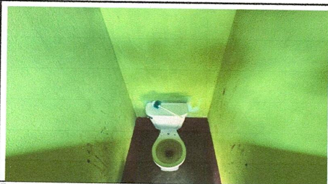
Foto 9: Sustitución de inodoro
