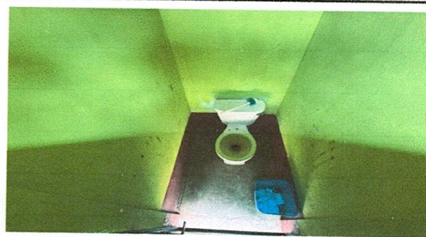
Foto 10: Sustitución de inodoro
