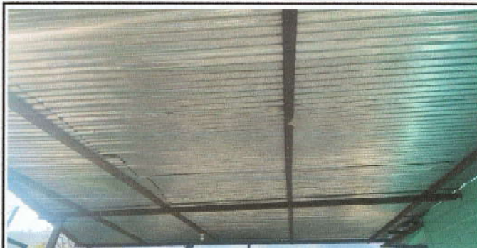
Foto 2: Mantenimiento a estructura de soporte de metal
