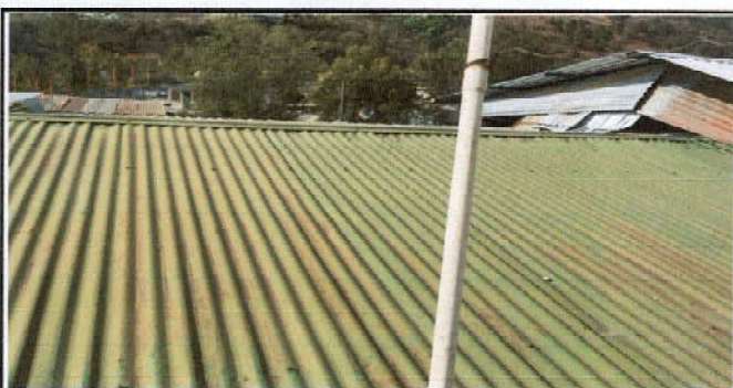
Foto 5: Sustitución de capote
