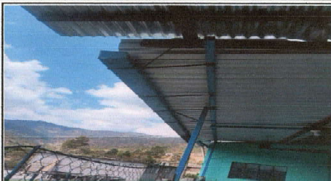
Foto 9: Mantenimiento a balcones de metal
