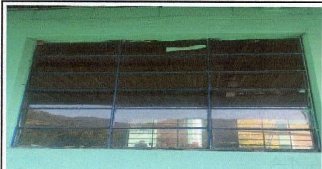
Foto 3: Sustitución de ventana por ventana corrediza
