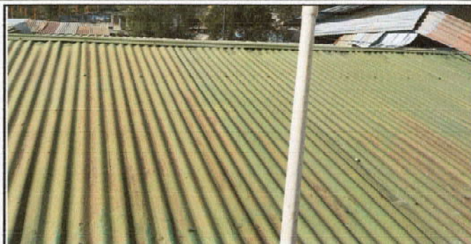
Foto 8: sustitución de lamina por lámina troquelada calibre 26
