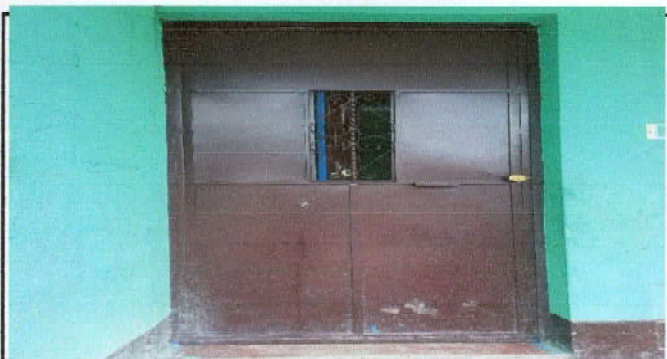
Foto 11: Mantenimiento de puerta
