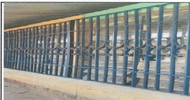
Foto 9: Mantenimiento a balcones de metal
