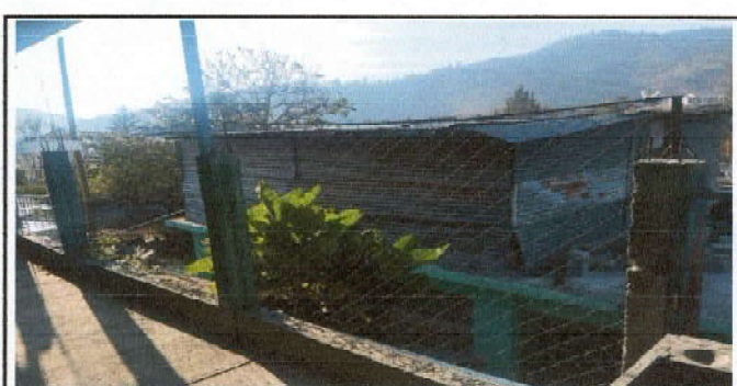
Foto 12: Sustitucion de baranda
