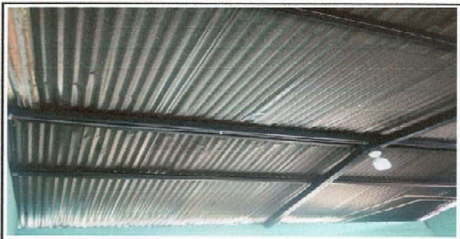
Foto 4: Sustitución de estructura de metal por metal
