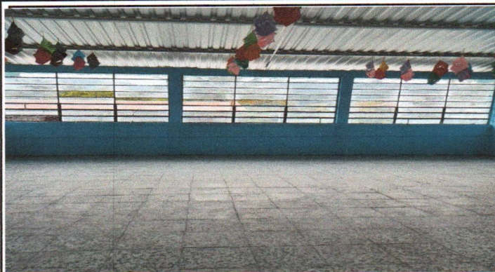
SUSTITUCIÓN DE PISO GRANITO
