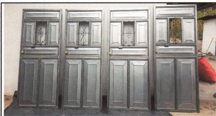
SUSTITUCIÓN DE PUERTAS DE METAL
