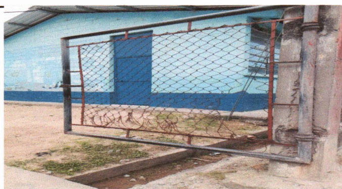
REPARACIÓN DE PORTON DE MALLA
