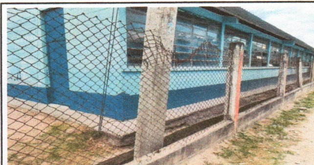
FOTO 5: Sustitución de malla galvanizada y tubo HG
