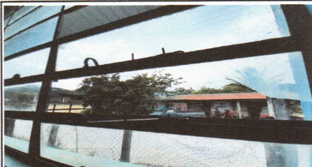
FOTO 4: Sustitución de vidrios
