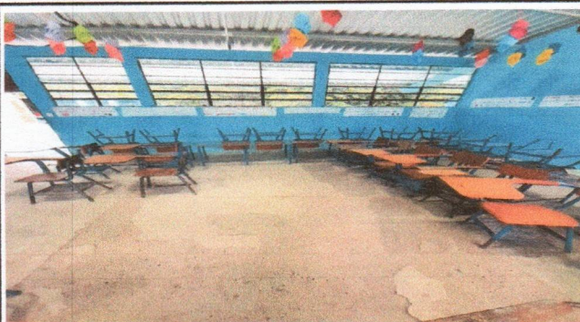
FOTO1: Sustitución de piso granito
