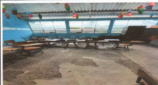
FOTO 2: Sustitución de piso granito
