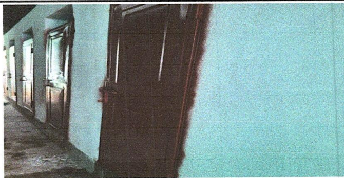
Foto 10: Puertas de los baños en buen estado
