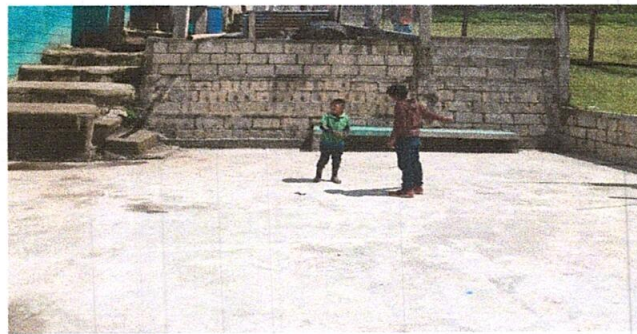
Foto 8: Sustrucción de piso
