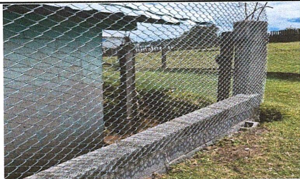
Foto 12: Malla galvanizada en buen estado
