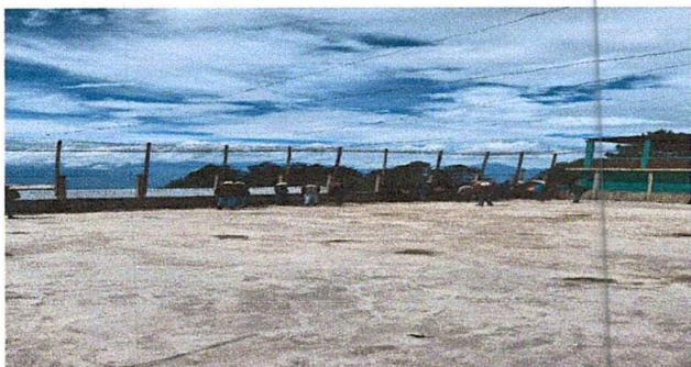
Foto 7: Sustrucción de piso de concreto
