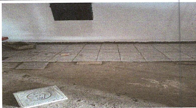
Foto 9: Sustrucción de piso por granito
