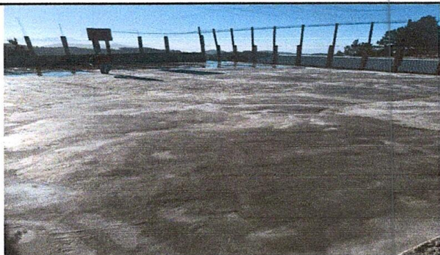
Foto7: Sustrucción de piso de concreto
