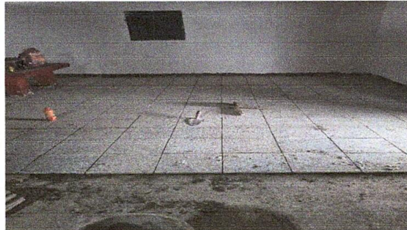
Foto 2: Sustitución de piso
