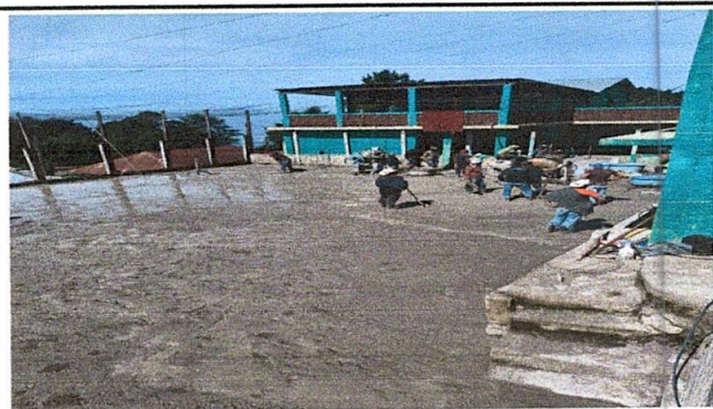
Foto 3: Sustitución de piso
