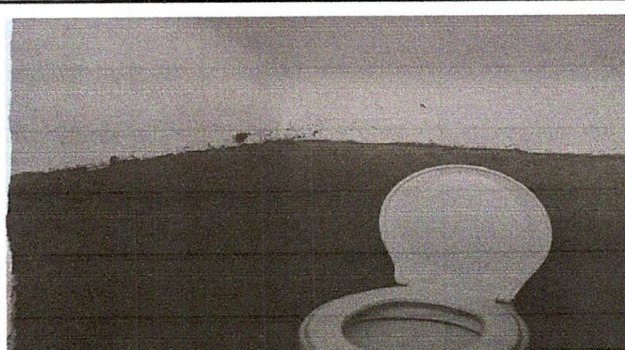
Foto 4: Sustitución de baños
