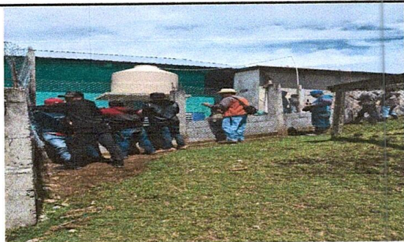
Foto 5: Reparación de muro perimetral
