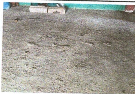
Foto 2: Sustitución de piso
