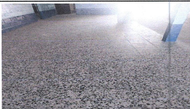
1: SUSTITUCIÓN DE PISO POR PISO GRANITO
