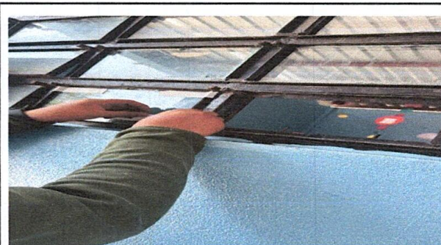
4: SUSTITUCIÓN DE VIDRIOS
