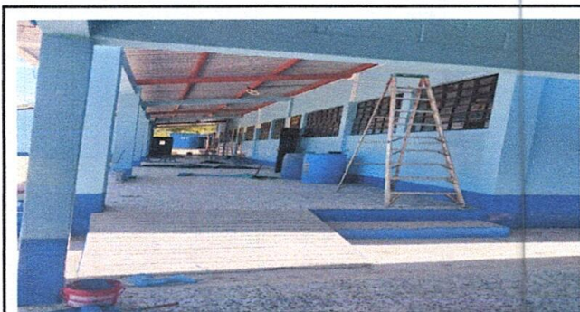
5: PINTURA EN MODULOS
