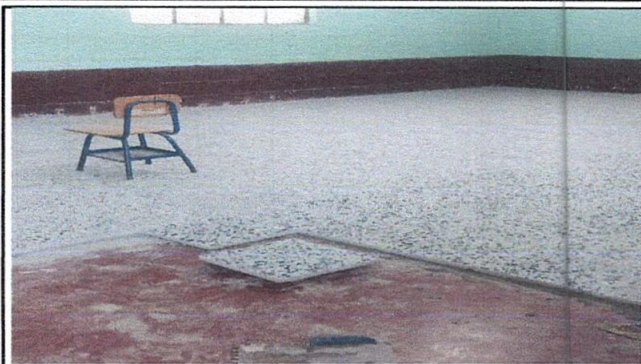
1: SUSTITUCIÓN DE PISO PORPISO GRANITO
