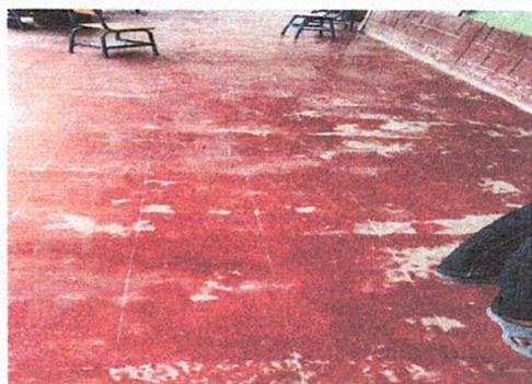
Foto 3: Sustitución de piso torta de cemento
