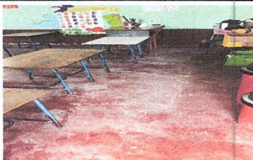
Foto 5: Sustitución de piso dentro de las aulas
