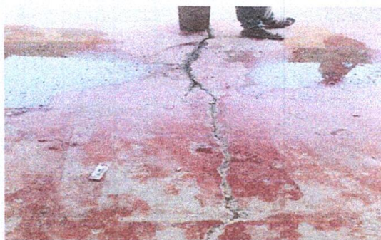
Foto 4: Sustitución de piso agrietada
