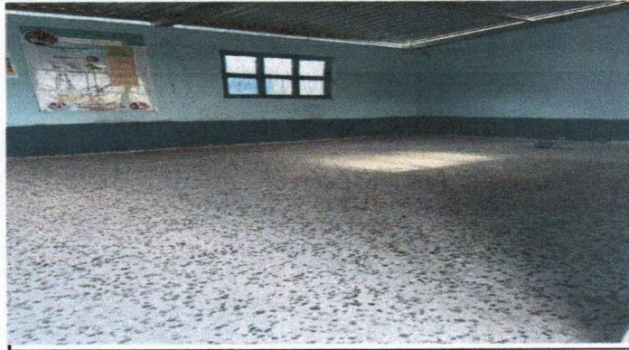
SUSTITUCIÓN DE PISO GRANITO
