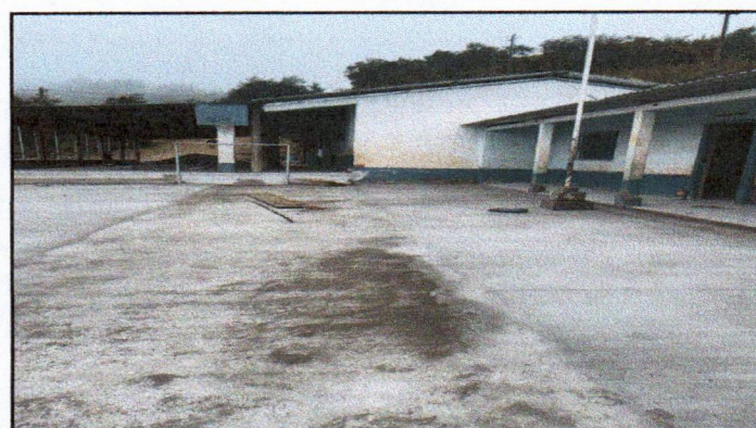
SUSTITUCIÓN DE LOSA DE PATIO
