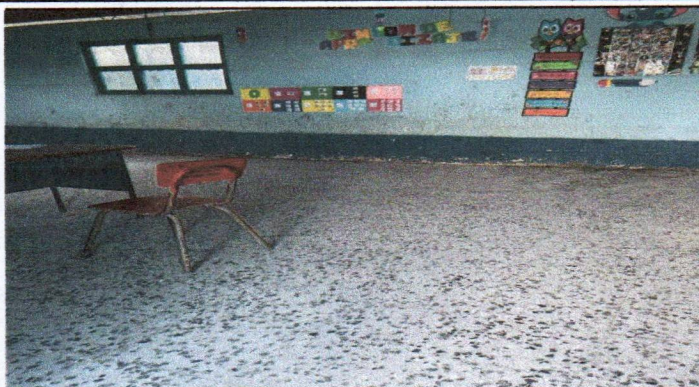
SUSTITUCIÓN DE PISO GRANITO
