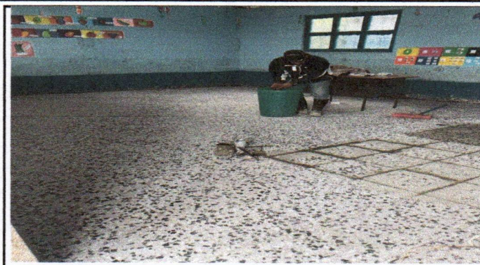
SUSTITUCIÓN DE PISO GRANITO
