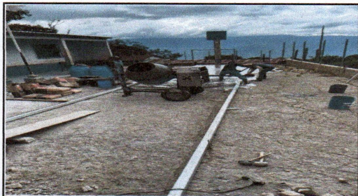
SUSTITUCIÓN DE LOSA DE PATIO
