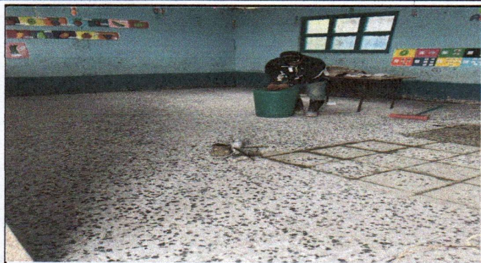
SUSTITUCIÓN DE PISO GRANITO
