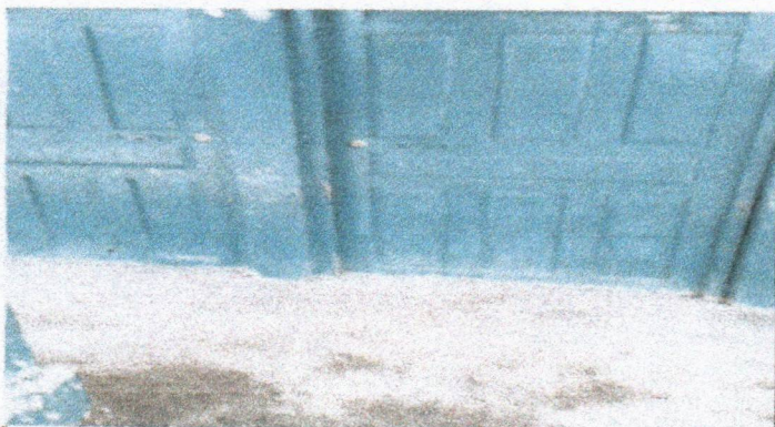
SUSTITUCIÓN DE PUERTAS DE MADERA POR METAL
