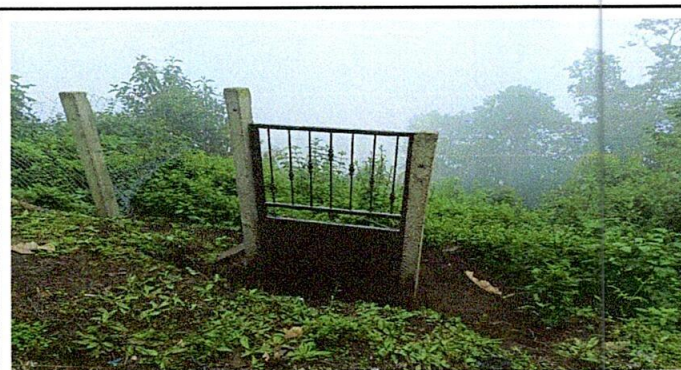
FOTO 3: SUSTITUCIÓN E PORTÓN
