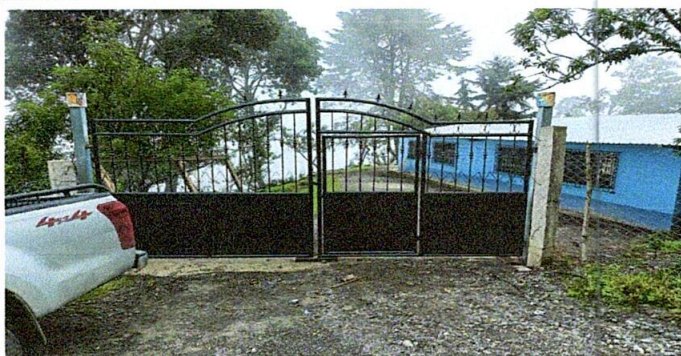
FOTO 1: SUSTITUCIÓN E PORTÓN
