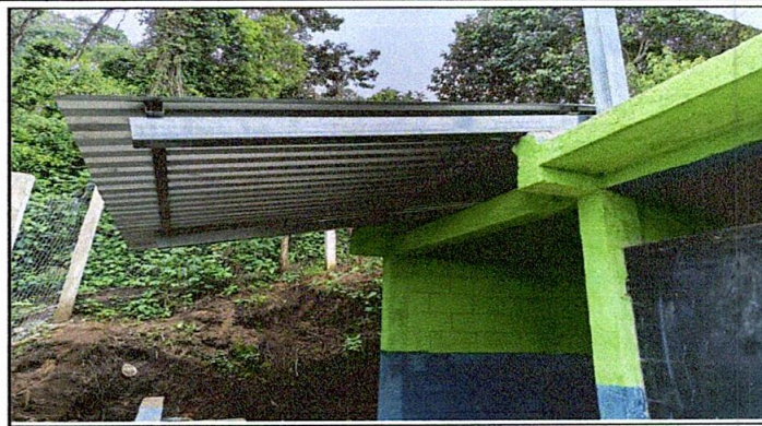
2: SUSTITUCIÓN DE SOPORTE
