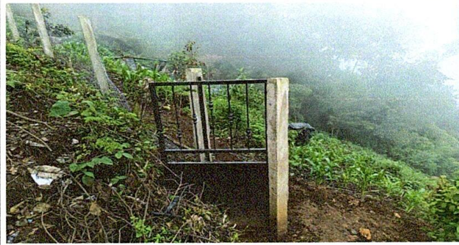
FOTO 2: SUSTITUCIÓN E PORTÓN
