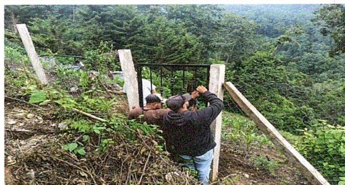
2: SUSTITUCIÓN DE PORTÓN
