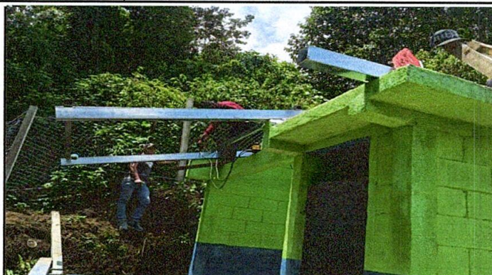
2: SUSTITUCIÓN DE SOPORTE
