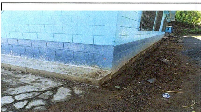
4: REPARACIÓN DE BANQUETA DE CONCRETO
