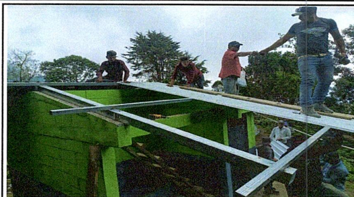
1: SUSTITUCIÓN DE LAMINA
