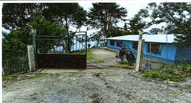
1: SUSTITUCIÓN DE PORTÓN
