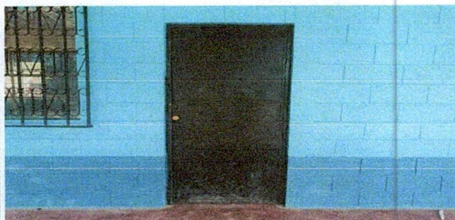
FOTO 5: Mantenimiento a puertas de metal
