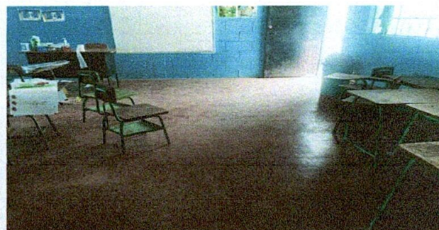
FOTO 4: Sustrucción de piso por piso granito
