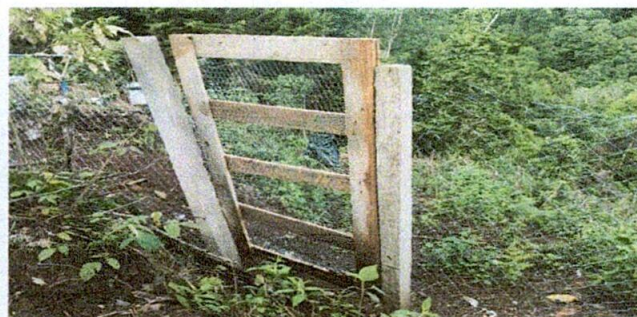
FOTO 2: Sustrucción de portón
