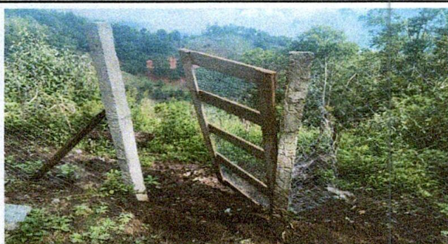
FOTO 3: Sustrucción de portón
