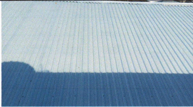
Foto 1: CUBIERTA DE LÁMINA
