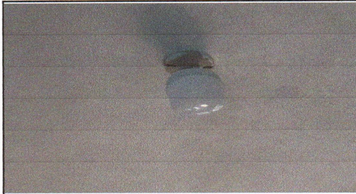
Foto7: REPARACIÓN DE SISTEMA ELÉCTRICO
