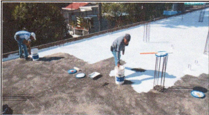
Foto 3: IMPERMEABILIZACIÓN DE LOSA
