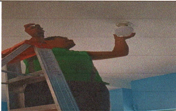
Foto7: REPARACIÓN DE SISTEMA ELÉCTRICO
