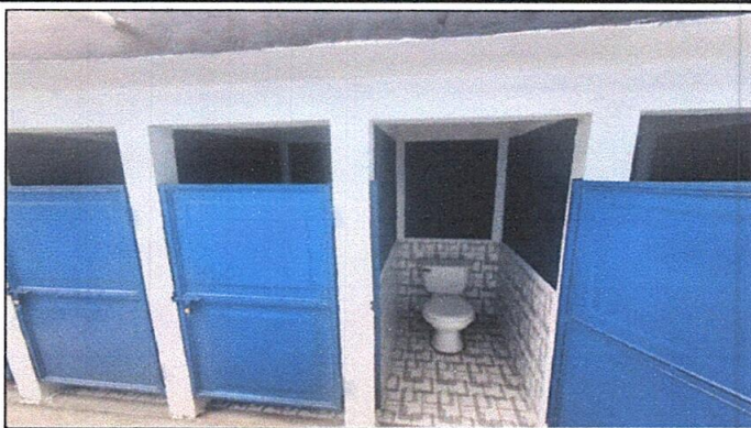
Foto 2: Remozamiento con sanitarios nuevos (5 sanitarios)
