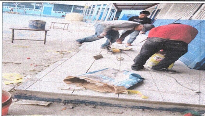
Foto 8: cambiando piso de torta de cemento en mal estado de corredor de 2 aulas y cocina, por piso de granito
