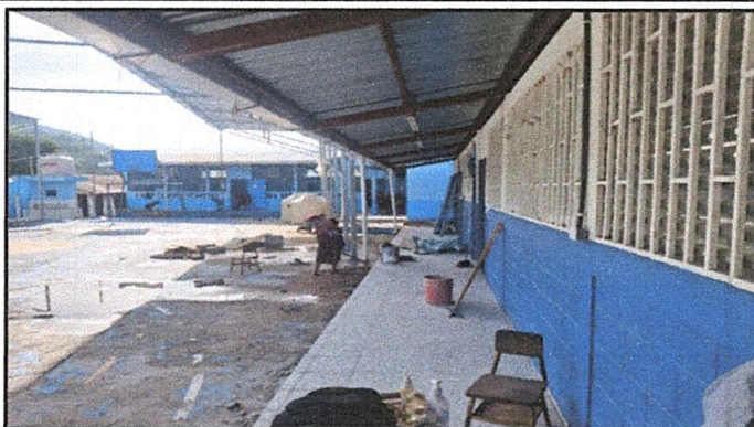
Foto 8: Piso de torta de cemento sustituido por piso de granito.
