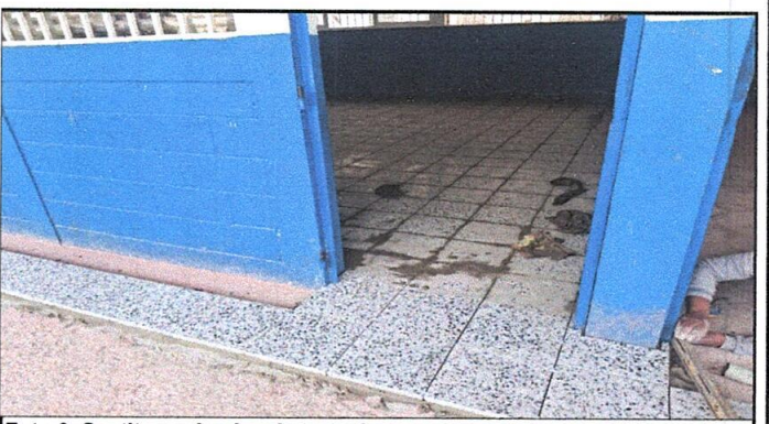
Foto 6: Sustituyendo piso de torta de cemento por piso de granito (2 aulas incluye corredor)
