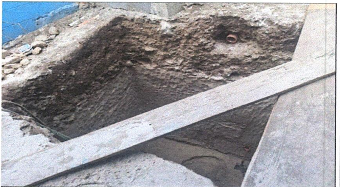
Foto 4: Mejoramiento de sistema de drenaje (fosa séptica)
