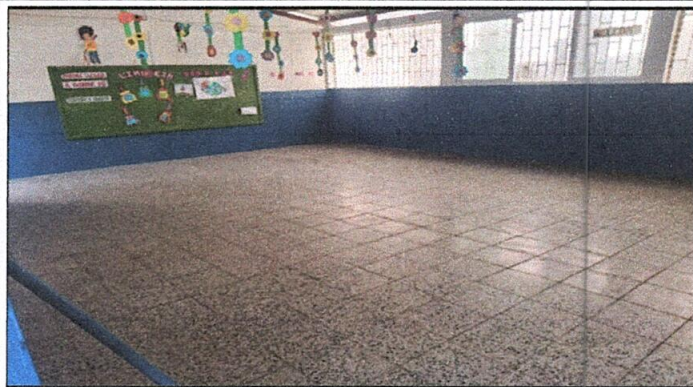
Foto7: Piso de torta de cemento sustituido por piso de granito (Aula 2 incluye corredor)
