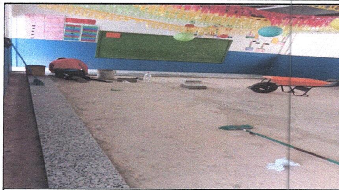
Foto 7: Cambiando piso de torta de cemento en mal estado, por piso de granito (aula 2 incluye corredor)
