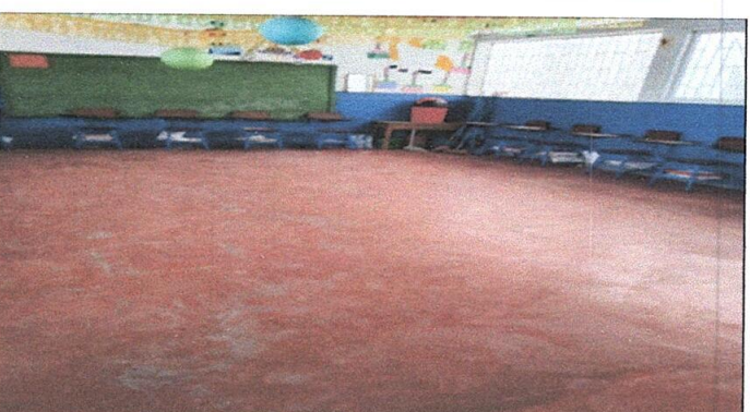
Foto 6: Piso de torta de cemento en mal estado, necesita ser sustituido por piso de granito (2 aulas incluye corredor)
