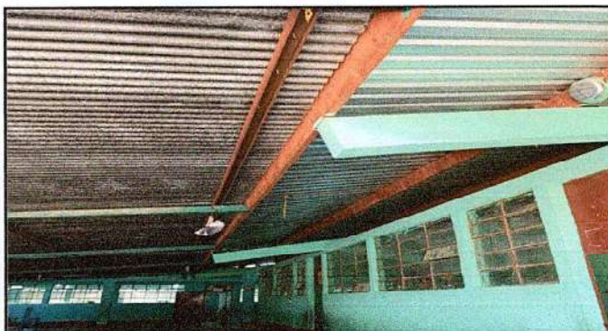
Foto 4: CAMBIO DE ESTRUCTURA DE METAL POR METAL
