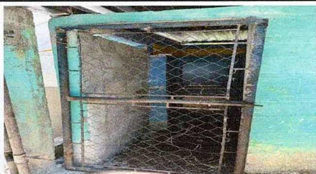
Foto 3: SUSTITUCIÓN DE PUERTA DE METAL PARA BAÑOS
