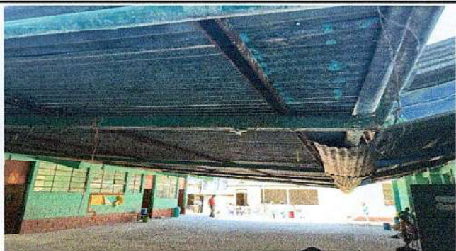
Foto1: CAMBIO DE LAMINA POR LÁMINA TROQUELADA
