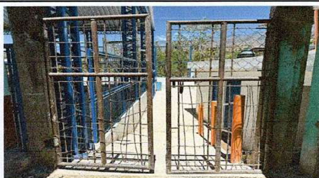
Foto 2: SUSTITUCIÓN DE PORTON PRINCIPAL
