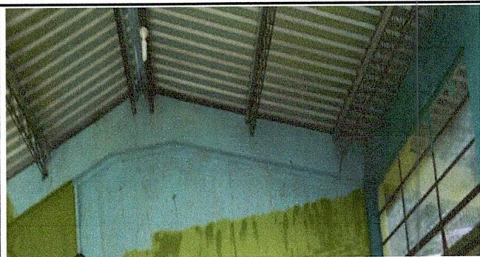
Foto 5: CAMBIO DE LAMINA DURALITA POR TROQUELADA
