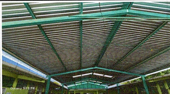
Foto 4: CAMBIO TECHO DEL PATIO
